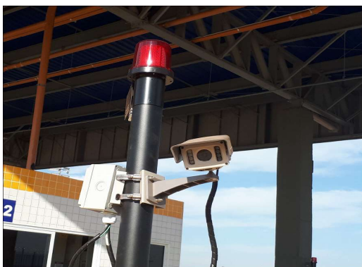
Figura 1 - Alarme sonoro e visual na parte superior do poste
