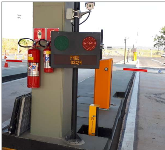
Figura 7 – ITSL – Indicador de Tarifa e Semáforo de Liberação
