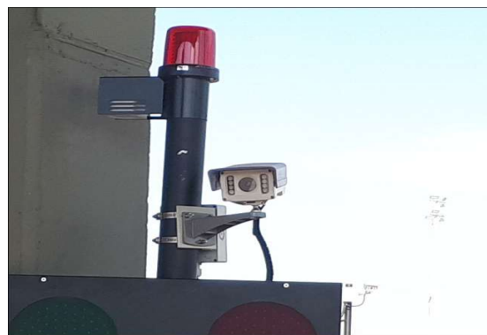
Figura 2 - Alarme sonoro e visual na parte superior do poste
